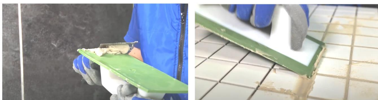
Рис. 34. Заполнение швов затиркой при помощи резинового шпателя
