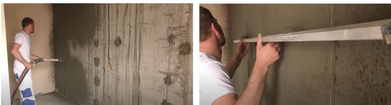
Рис. 25. Схема нанесения обрызга на поверхность и разравнивание правилами образовавшихся наплывов
